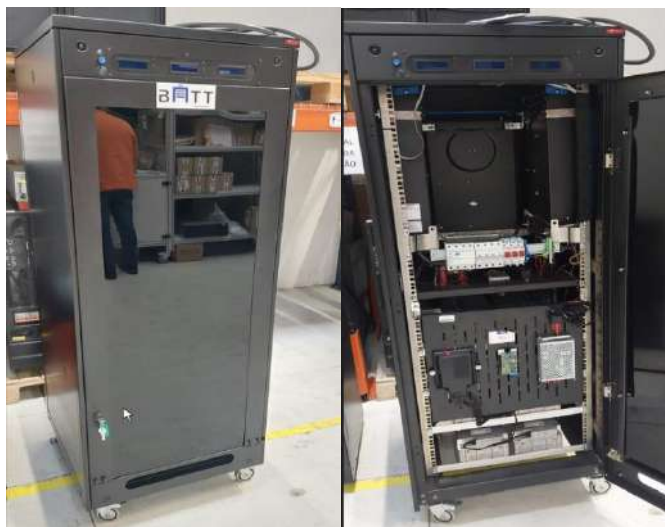
Figura 7 – Baterias de íão lítio provenientes de veículos elétricos ( 2nd life )
