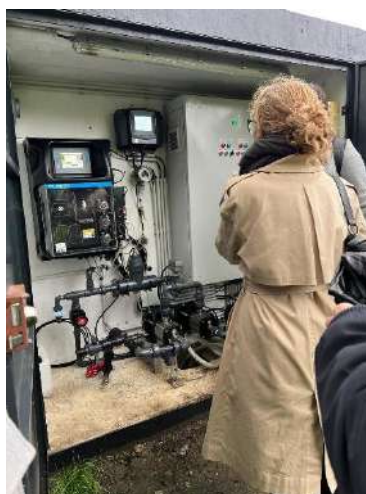
Figura 1 – 2ª Verificação ao local
