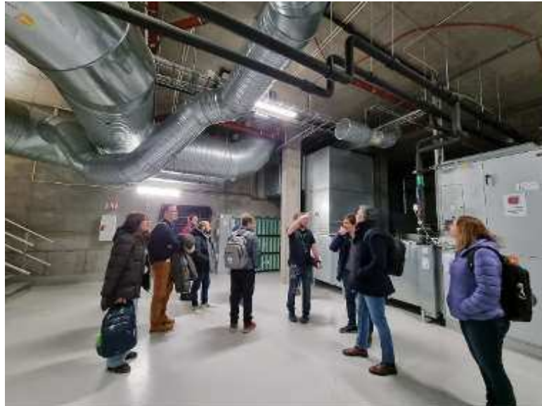
Figura 24: Studyvisit Brattøra: Sala de máquinas Powerhouse, HVAC
