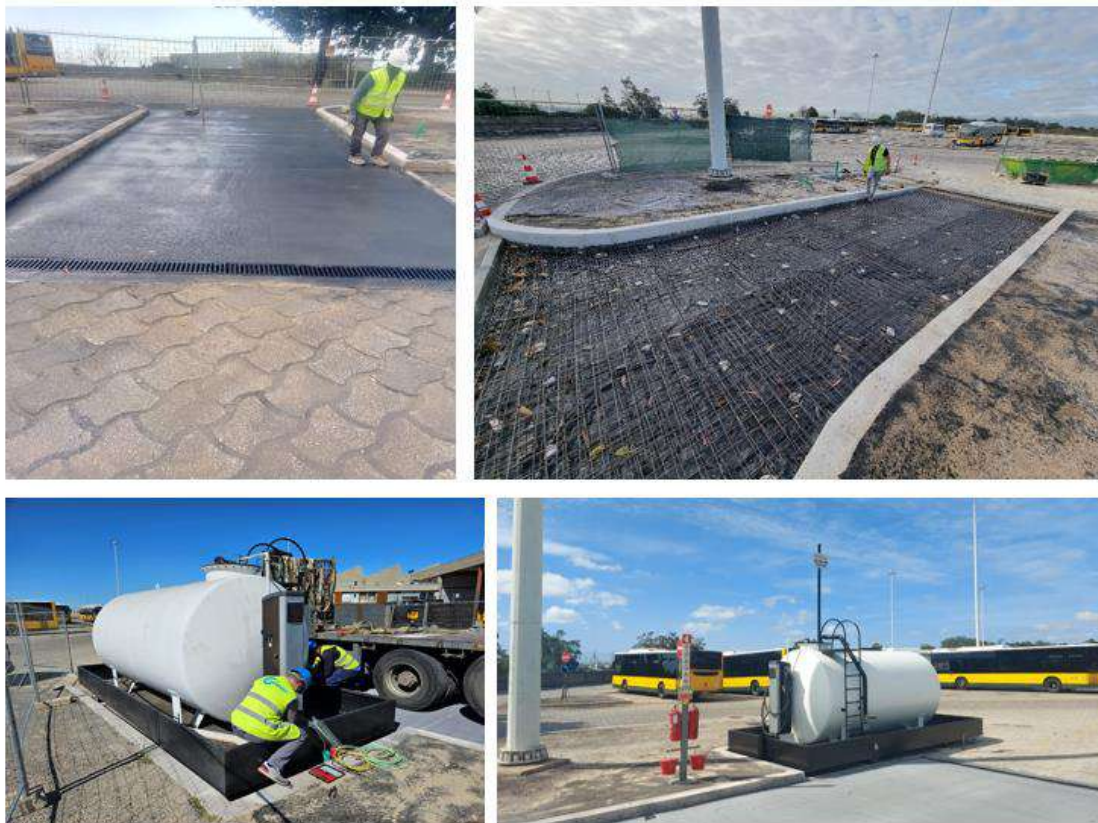
Figura 5.17 – Processo de instalação do SKID nas instalações da CARRIS
