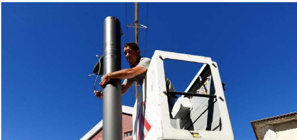
Figura 6.1 - Instalação e comissionamento das colunas/ postes inteligentes no recinto
