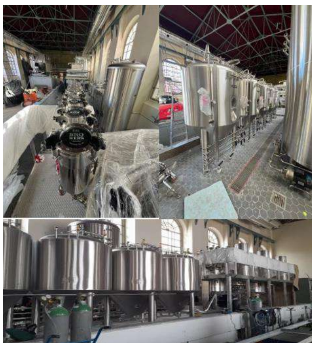
Figura 5.10 – Espaço Browsers Beato da The Brewers Company no Beato Innovation District – fase final de construção (maio 2024)
